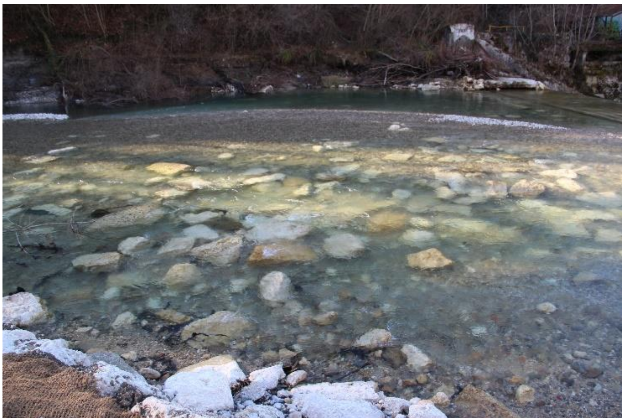
51 - Les blocs arrachés et charriés jusqu'au seuil du barrage
