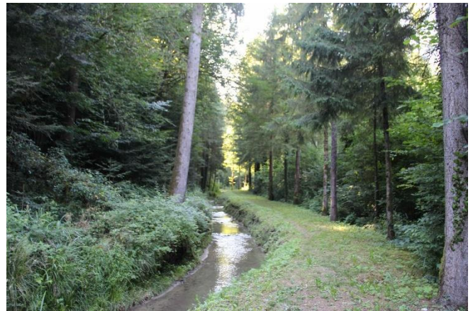
33 - Le canal d'aménée d'eau (800 mètres de longueur)
