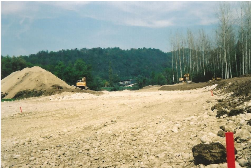
13 Les travaux en 2004
